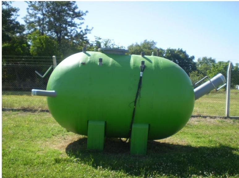
**Foto15:** Reactores anaeróbicos para el tratamiento de efluentes líquidos (INTA Castelar – IMyZA)
